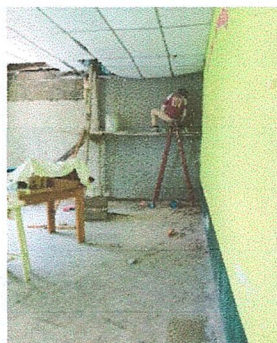
Foto 3: Inicio de la resanación de la pared del salón del clases.
