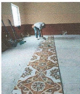
Foto 1: Inicio de colocación de piso en el primer salón.
