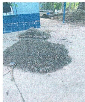
Foto 4: Materiales a utilizar en la mejora del patio que se encuentra frente a la dirección.
