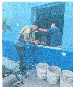
Foto 2: Colocación de ventanas en la dirección
